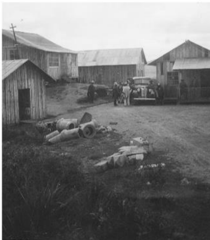
Campamento del ferrocarril en Mosquera, durante la construcción del tramo El Tambo-Biblián.
