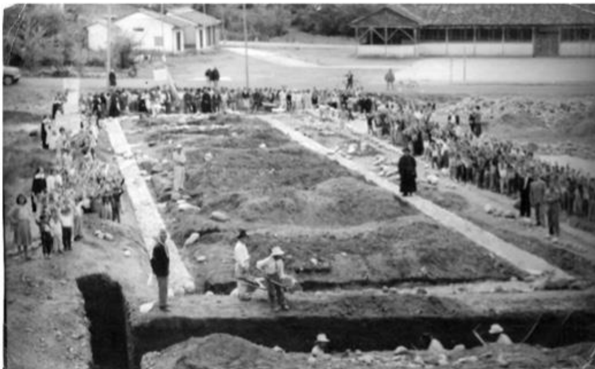
Avance de la construcción de la nueva escuela de las Madres Oblatas. 1964-1970.
