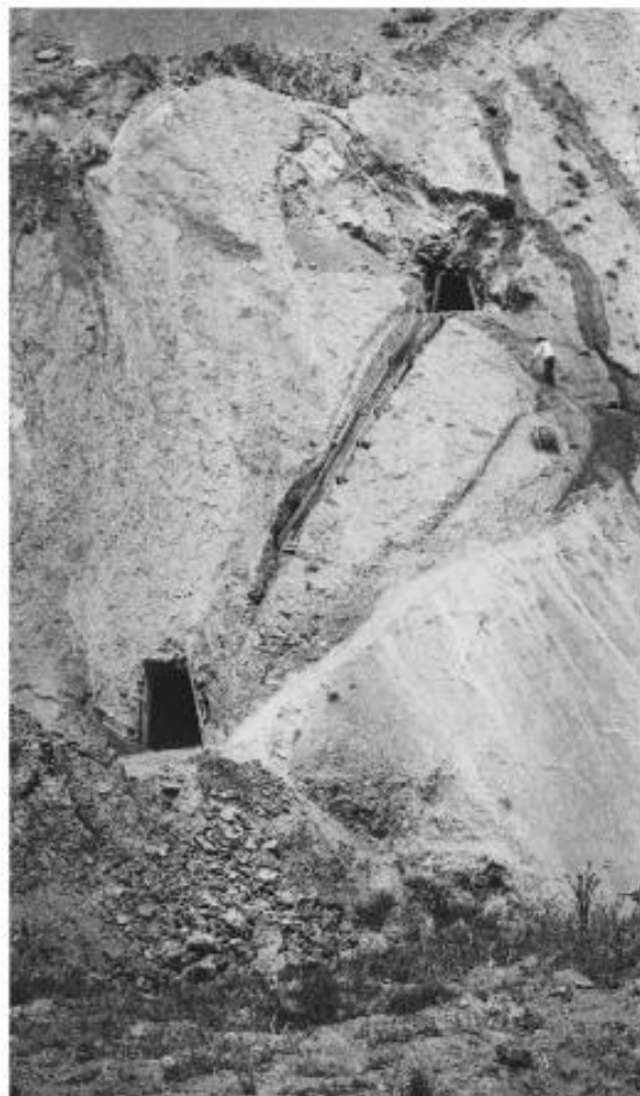
Mina Fortuna, ingreso de galerías. La galería inferior tiene 118 metros y la superior 62 metros. 1938.
