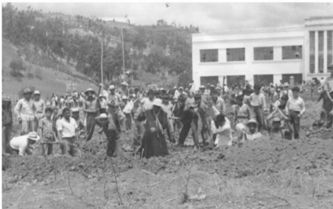
El párroco José Benigno Iglesias, con ayuda de la población, lidera los trabajos para la construcción de la nueva escuela Corazón de María. 1964-1970.
