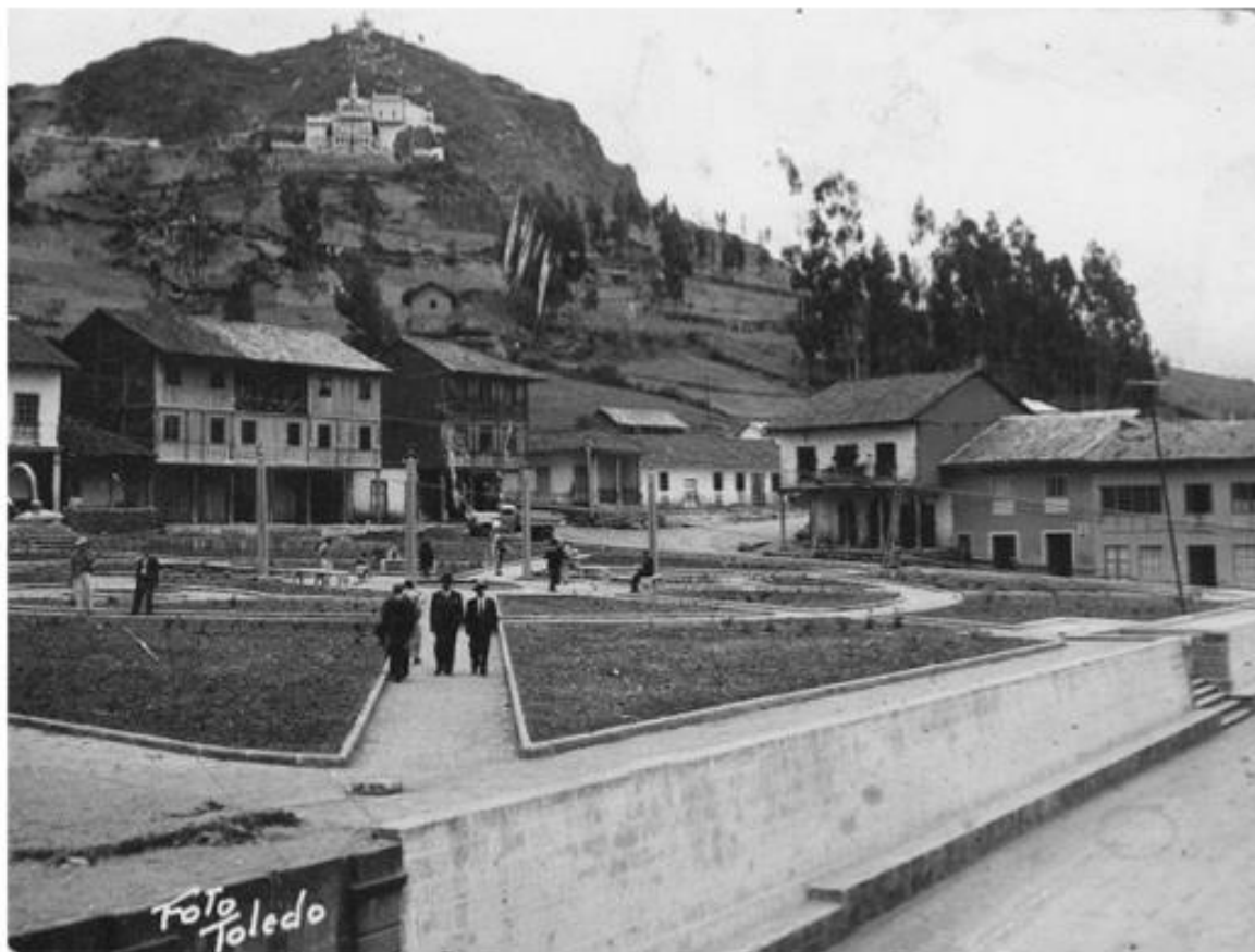
Parque central de Biblián en construcción. 1930-1940. Foto: Toledo.
