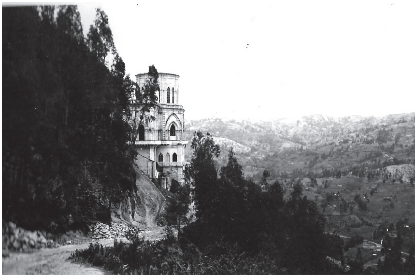
El Santuario del Rocío captado desde la parte norte. Se puede observar la vía que conduce a la cantera de Atar, construida por los pobladores de la zona. Foto: Derechos reservados del autor. 1960-1970.
