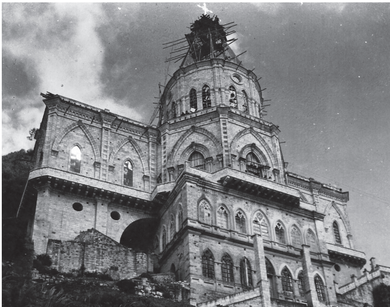
Los andamios de madera de eucalipto y caña guadua, para la construcción de la cúpula, fueron donados por José Andrade Vicuña. Foto: Derechos reservados del autor. 1960-1970.
