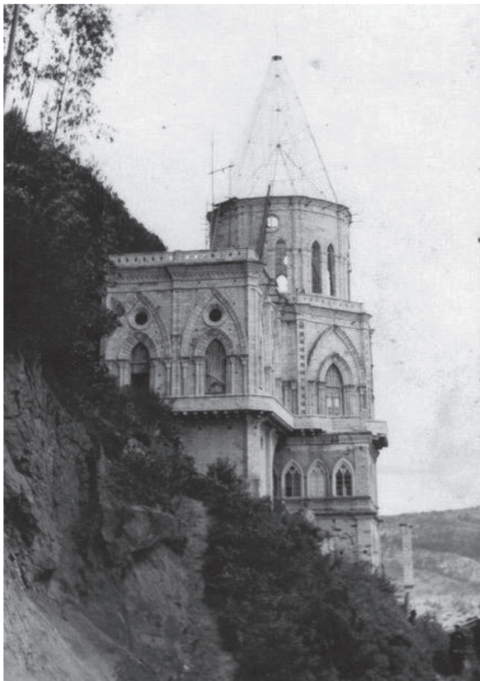
Imágen del Santuario del Rocío durante la construcción de la cúpula. La estructura metálica fue confeccionada por el maestro cuencano Luis Tamayo. Foto: Derechos reservados del autor. 1960-1970.
