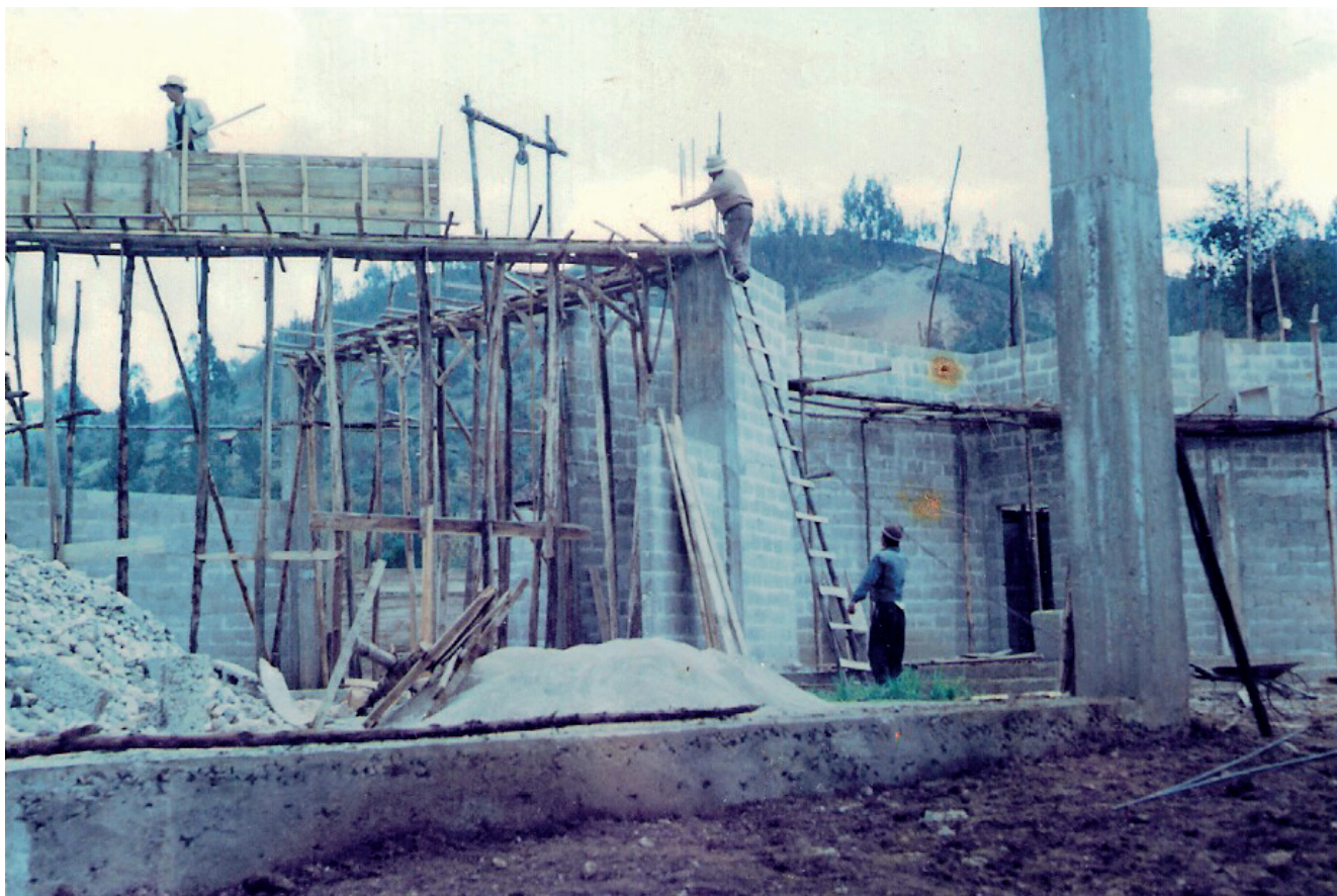
Obreros trabajan en la construcción de la nueva iglesia matriz de Biblián. El templo parroquial fue levantado en el mismo lugar donde se encontraba la antigua iglesia central. Derechos reservados del autor. 1970-1975. Foto: Cortesía de Luis Acevedo.
