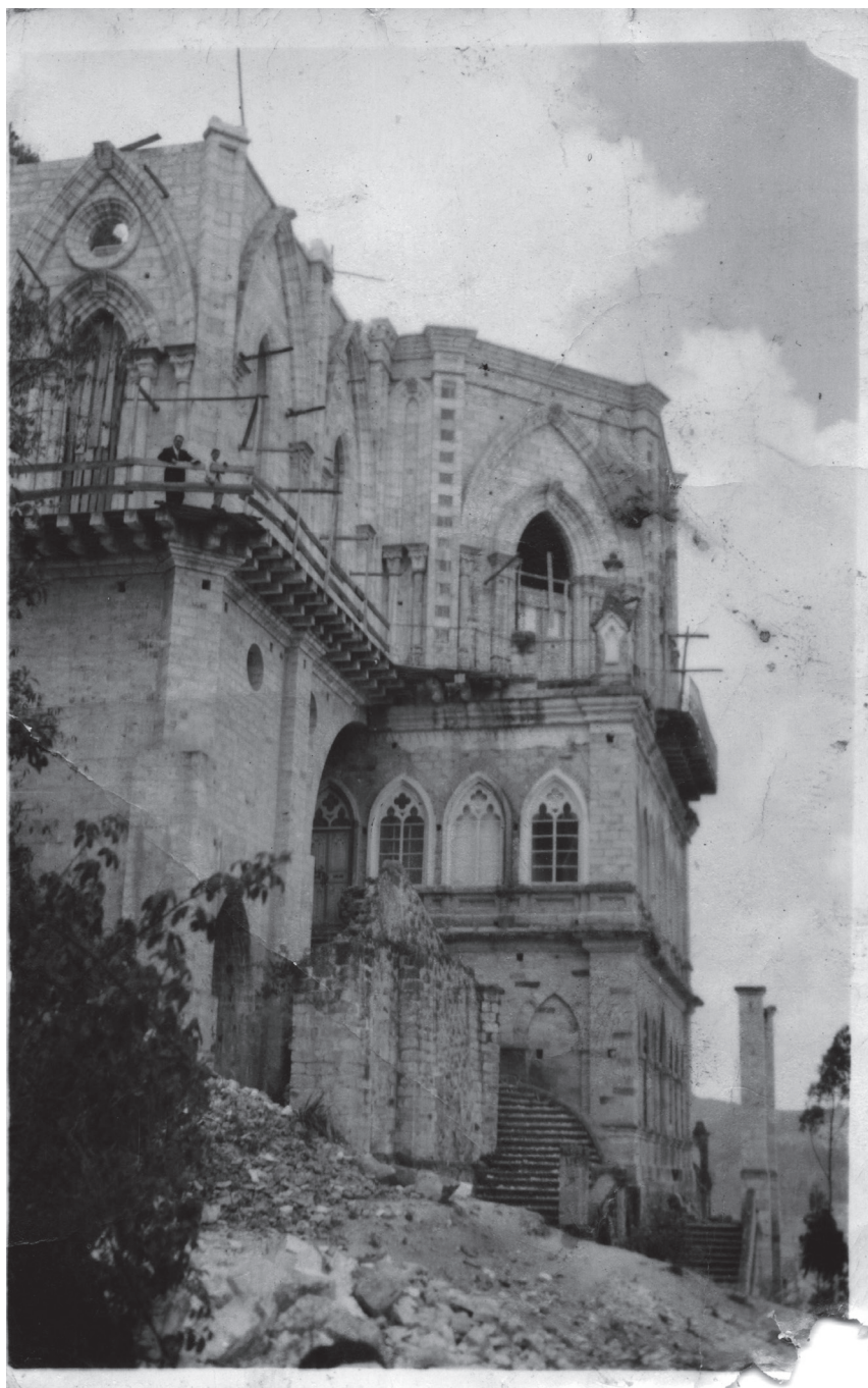
Las naves lateral izquierda y central, fueron levantadas sobre la estructura del antiguo santuario. Foto: Francisco Idrovo Espinoza. 1950-1960.
