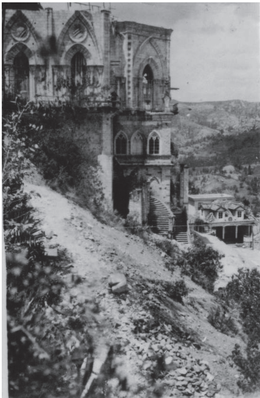
La nave lateral izquierda en proceso de construcción. Esta nave se edificó con piedras procedentes de la cantera de Atar. Foto: Derechos reservados del autor. 1950-1960.
