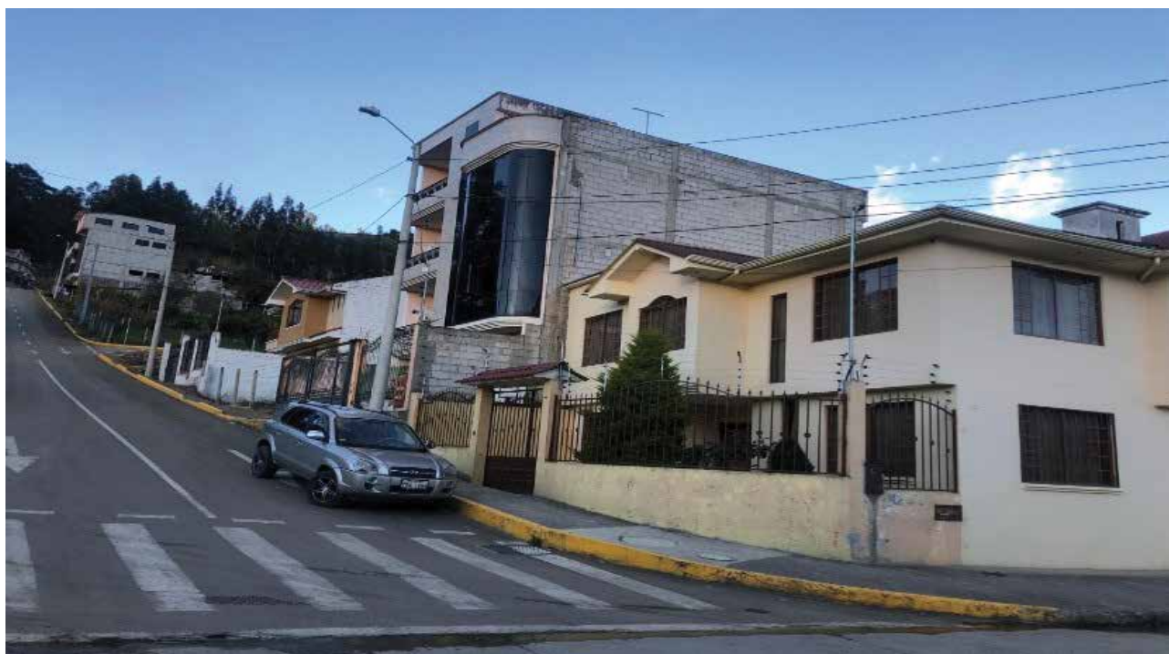
Foto 15. Desde hace 40 años aproximadamente, la vivienda rural y urbana de Biblián, se modernizó, con estructuras de hormigón y bloque y en los más diversos modelos y tamaños, de migrantes o de sus familias.
