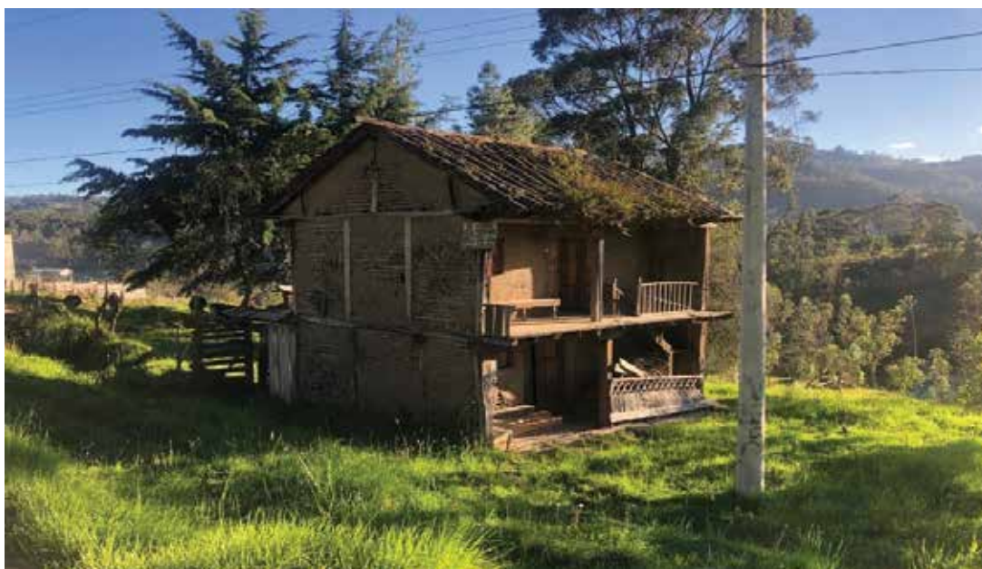
Foto 6. La clásica vivienda rural, de bareque, evidencia el abandono de sus propietarios, seguramente, migrantes (DRA).
