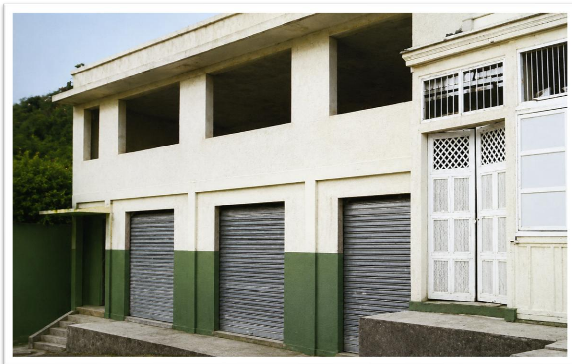
Edificio de Socorros Mutuos de Biblián. 1974. Foto. DRA.
