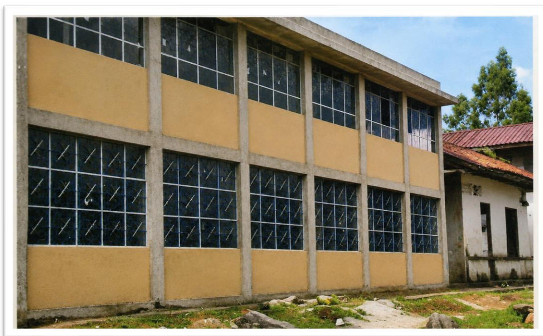
Bloque de aulas de la escuela de las madres Lauritas de Nazón. 1974. Foto. DRA.
