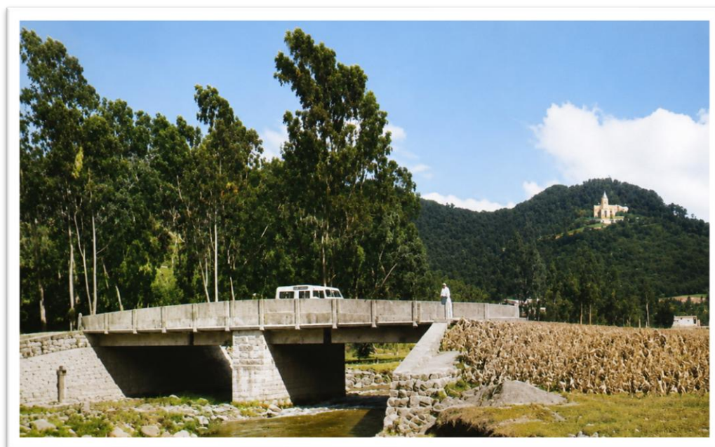
Puente de hormigón armado al ingreso del colegio José B. Iglesias. 1974. Foto. DRA.
