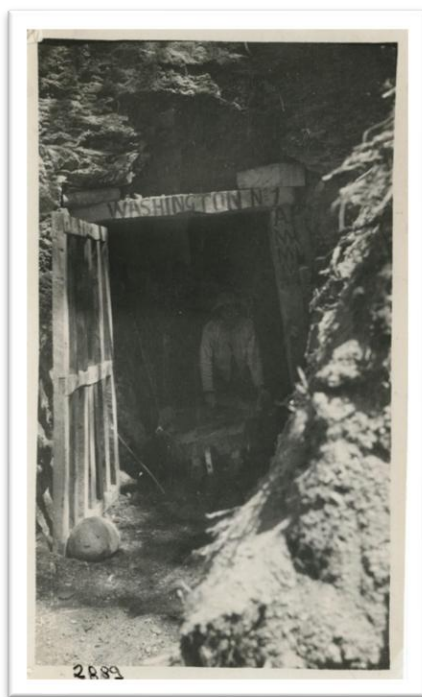
Ingreso a la mina Washington. Foto. INPC.
