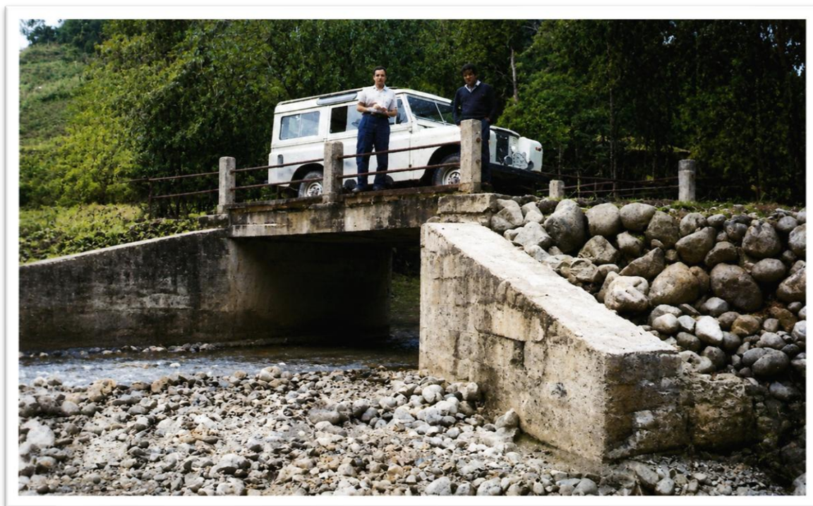
Puente sobre el río Galuay en el tramo Nazón-Galuay. 1974. Foto. DRA.
