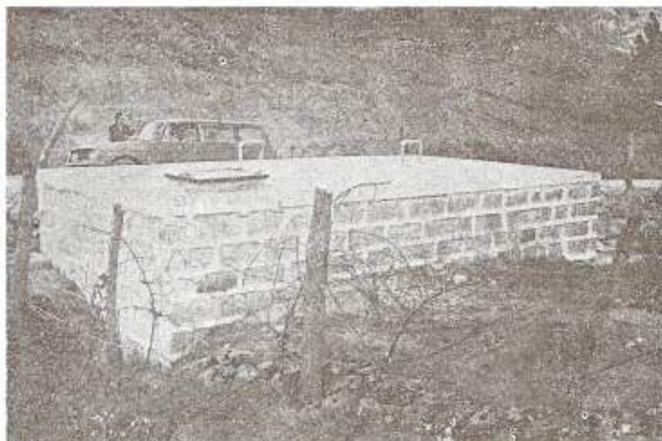
Instalación de agua potable para el importante sector de Cashicay.
