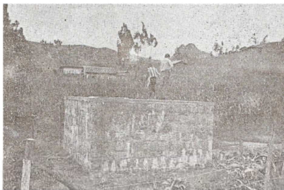
Tanques de agua potable para el caserío de Pishumaza.
